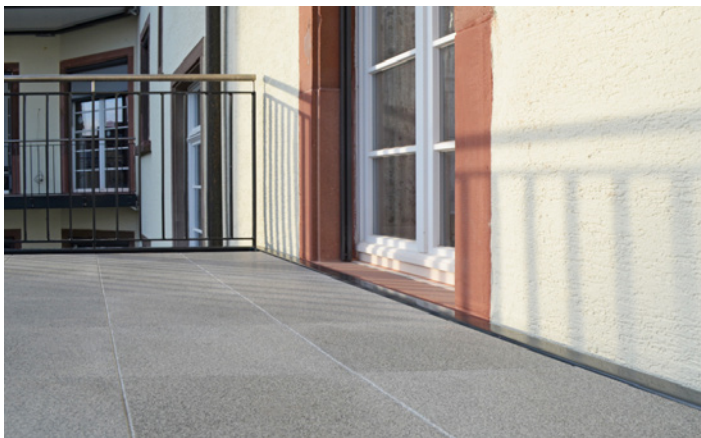
Die Balkone sind schwellenlos begehbar. Als Belag wurden die besonders robusten Betonwerksteinplatten gewählt.
