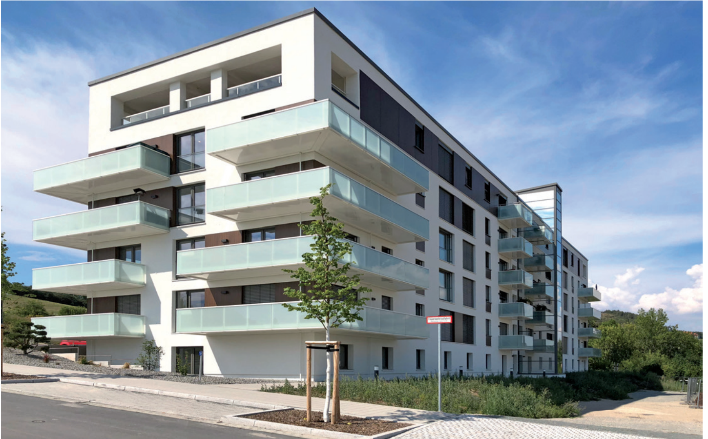
Spittelmeister-Balkone als große, freitragende Balkone – teilweise über Eck gebaut. Die Balkonverkleidungen sind aus mattweißem Glas.
