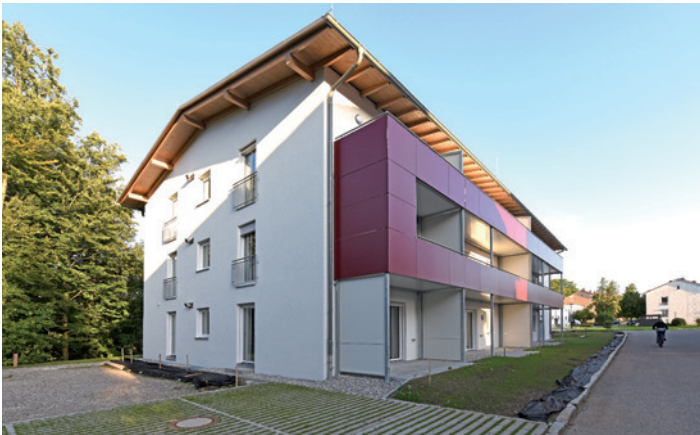
Spittelmeister-Systembalkone aus Stahl auf vier Stützen. Im Kontrast dazu die Balkonverkleidungen aus roten Tresaplatten.
