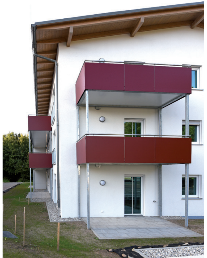
Hochwertige Edelstahlgeländer und Sichtschutzwände mit weißer Tresapfüllung runden das stimmige Gesamtbild ab.
