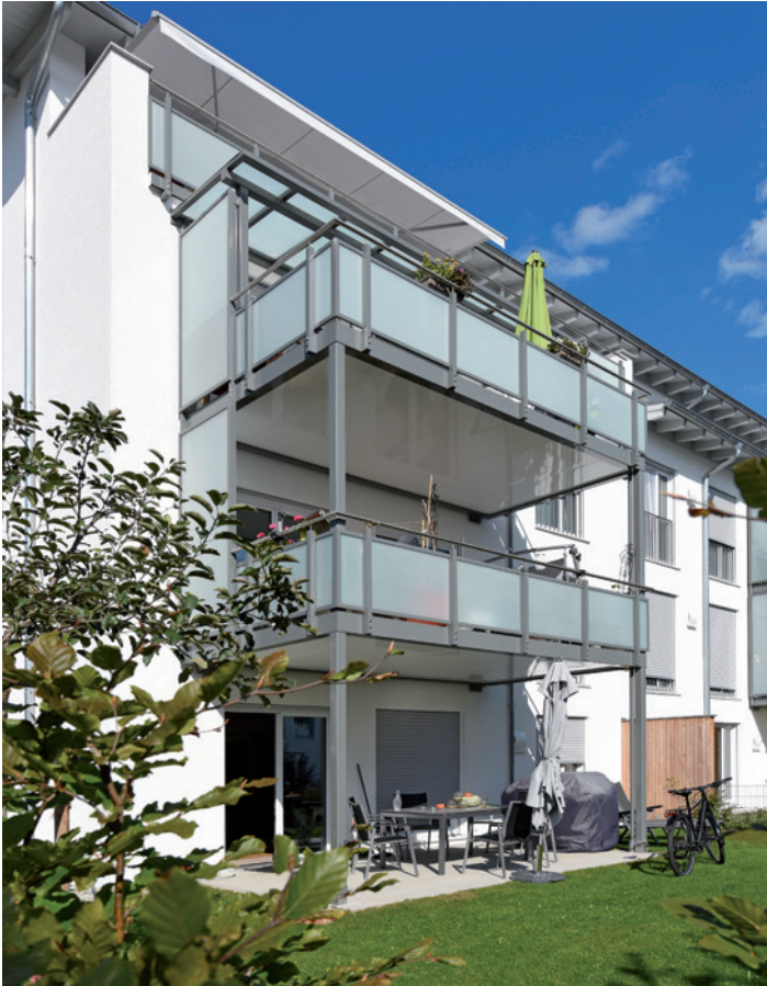
Die elf Wohneinheiten je Wohnhaus verfügen über großzügige, helle Grundrisse. Alle Eigentümer bzw. Mieter freuen sich über einen großen Balkon bzw. ihre Terrasse.
