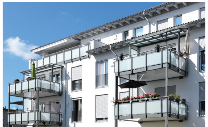
Spittelmeister-Systembalkone am Neubau. Die Zwei-Stützen-Anbau-balkone sind komplett aus Aluminium. Die Brüstung ist verkleidet mit mattweißem Glas. Hochwertige Edelstahlhandläufe und Balkondächer komplettieren den Freisitz.
