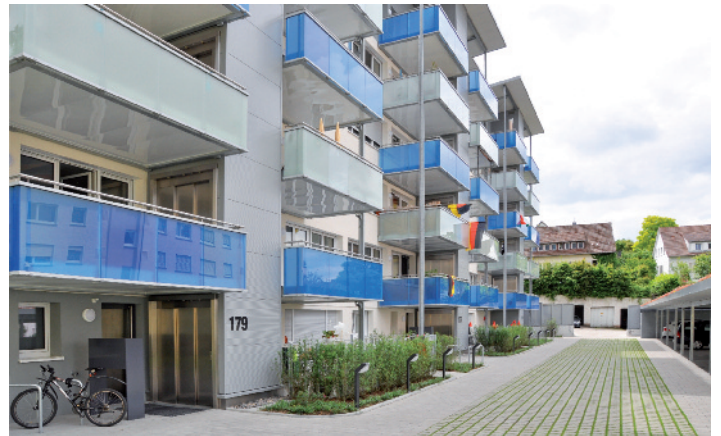
Der Zugang zu allen Wohnungen erfolgt nun mit dem Aufzug barrierefrei über den Balkon. Der Haupteingangsbereich wurde auf die gegenüberliegende Seite des Gebäudes verlegt.
